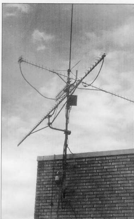
Het antennepark van PI8DRE. De verticale rondstraler is van de LAP, 9600 bps op 430.850 MHz. De 23 centimeter beams zijn van de interlink-verbindingen. Het kleine vierkante plaatje is de 23-centimeterantenne voor de communicatie met de sysop. Deze foto's werden vlak na een reparatie gemaakt: de coax-kabels hangen nu nog los en zullen spoedig daarna worden bevestigd.
